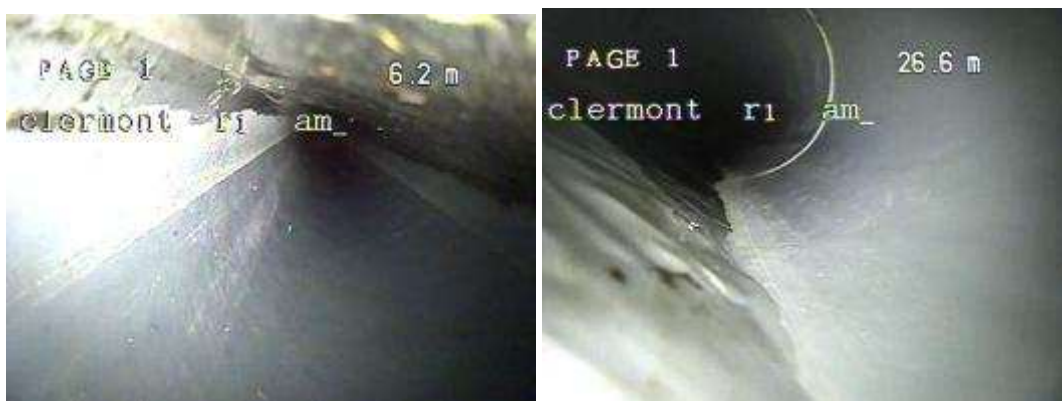
R1 vers R2 : canalisation remplie d'eau à plus de 50 % vers 6 m et écoulement d'eau vers 26 m
